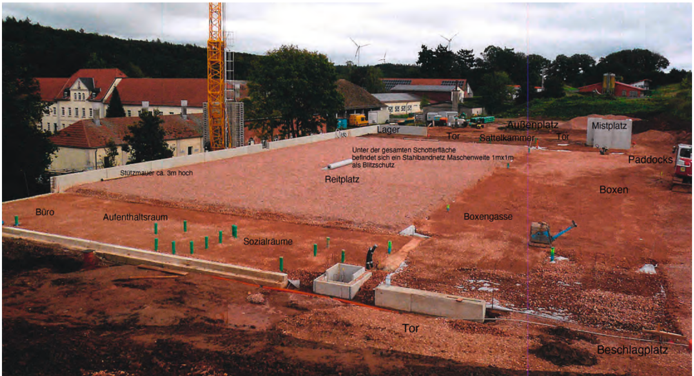
Übersicht über die entstehende Reitanlage
